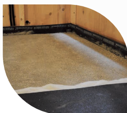
Układanie maty akustycznej
